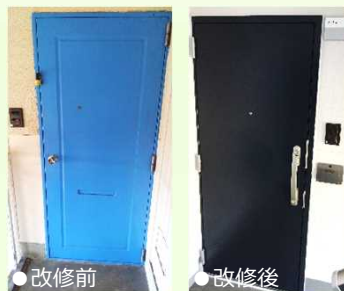
玄関扉の断熱改修
