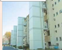
エレベータ設置
